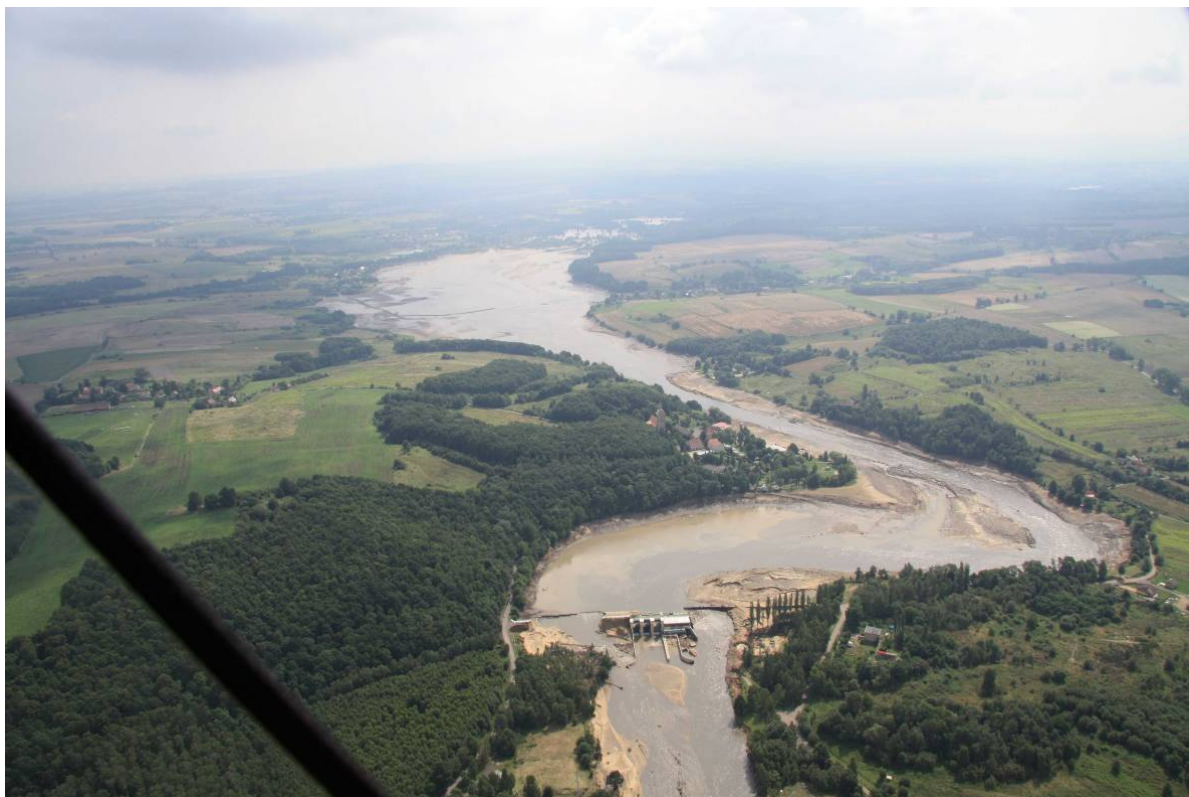
Abb. 15: Zerstörter Damm der Talsperre Niedow und das Tal der Witka am 08.08.2010 (Foto: SMI)
