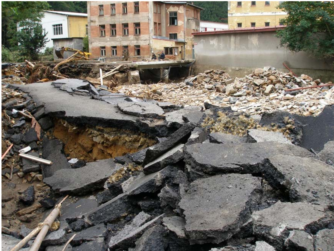
Abb. 11: Schäden verursacht durch die Směda in Frýdlant (Foto: Povodi Labe am 13.8.2010)
