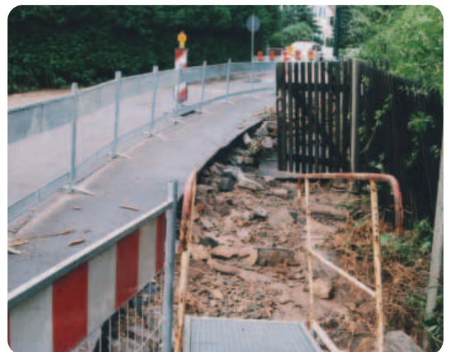
Abbildung 7-25: Unterspülte Straße durch den Lockwitzbach (Foto: Umweltamt Dresden, 2002)
