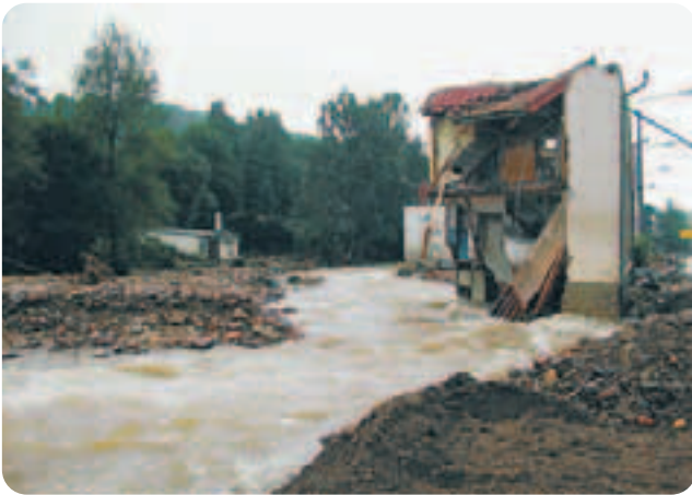
Abbildung 12-14: Zerstörtes Gebäude und Uferbereich sowie veränderter Fließweg der Roten Weißeritz nach dem Hochwasser am 12./13.08.2002 in Schmiedeberg (Foto: Gottfried Herold, 2002)
