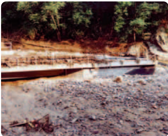
Abbildung 12-11: Schadstelle nach Schadenserstbeseitigung (Foto: LTV, 2002)
