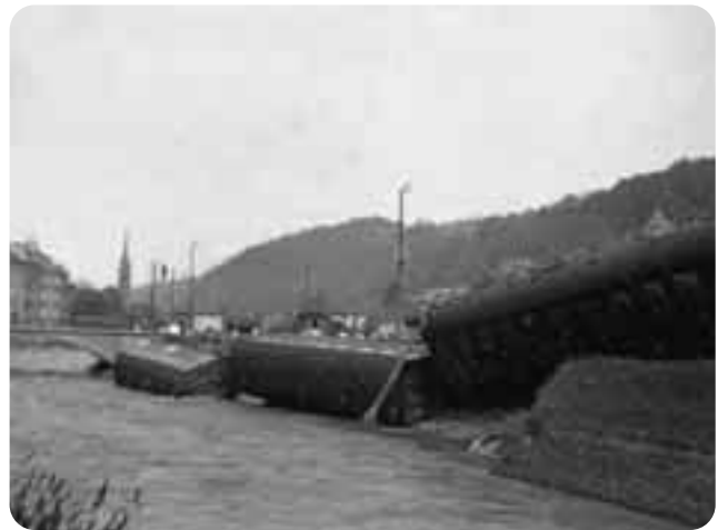
Abbildung 8-14: Bahnhof Triebischtal nach dem Hochwasser 1941 (Foto: Landratsamt Meißen, Untere Wasserbehörde)
