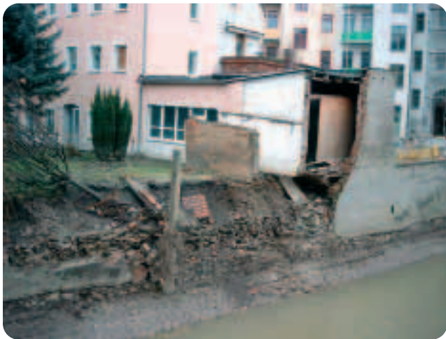
Abbildung 4-7: Beschädigung von Gebäuden infolge Einsturz der Ufermauer, Triebisch, Meißen (Foto: LTV, 2002)
