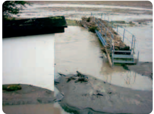
Abbildung 2-22: Pegelhaus und Messsteg der Pegelanlage Piskowitz 1 während des Hochwassers (Foto: UBG, 2002)
