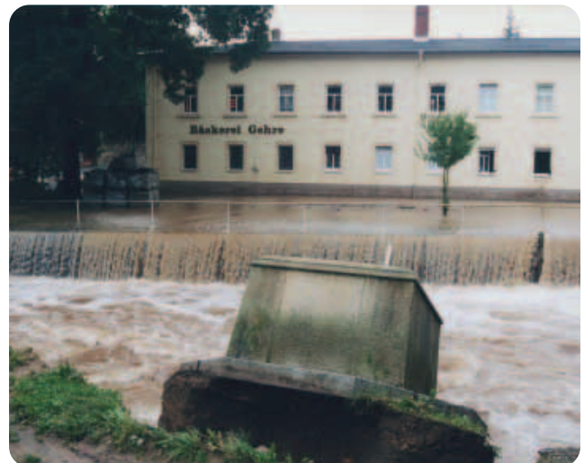
Abbildung 7-21: Überschwemmungen im Bereich Tögelstraße am 13. August (Foto: Umweltamt Dresden, 2002)
