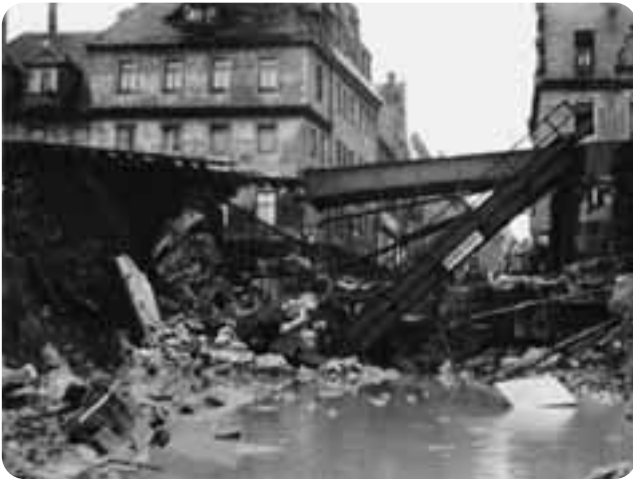
Abbildung 8-5: Pirna nach dem Hochwasser der Gottleuba 1957, Blick zur Eisenbahnbrücke (Foto: LTV)
