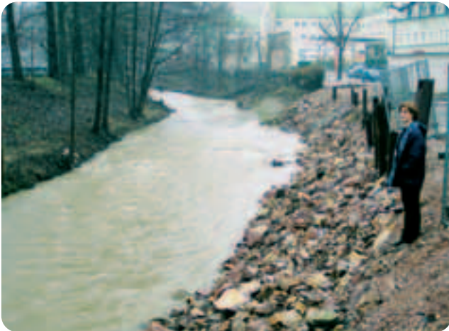
Abbildung 9-2: Leicht erodierbare Böschungssicherung im Prallhangbereich an der Triebisch, Stadtgebiet Meißen (Foto: Lukas Hunzinger, 2003)
