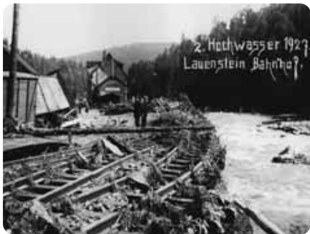
Abbildung 8-8: Bahnhof Lauenstein nach dem Hochwasser 1927 (Foto: aus POHL, 2003b)
