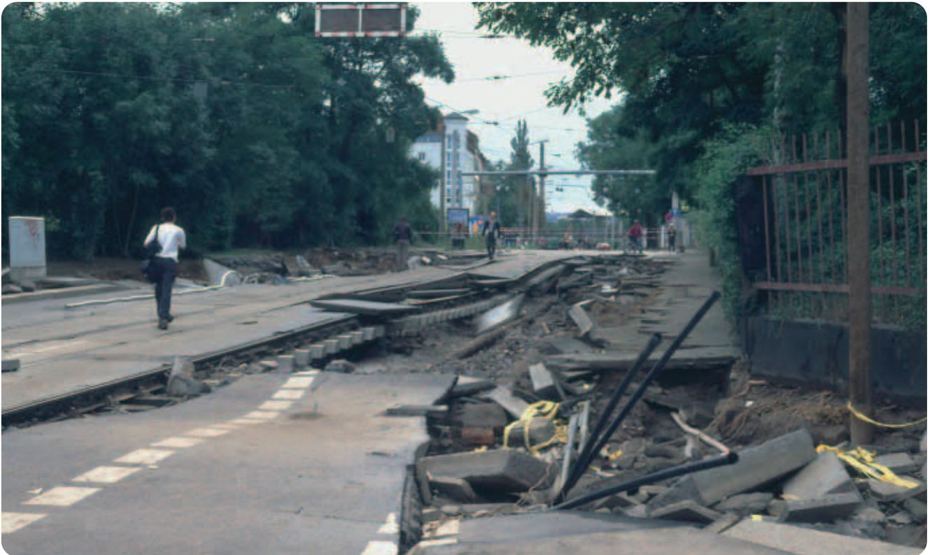
Abbildung 4-9: Erosionsschäden vor einer Bahnbrücken-Unterführung auf der Freiburger Straße in Dresden, Entfernung von der Vereinigten Weißeritz ca. 1 km (Foto: Siegward Elze, 2002)
