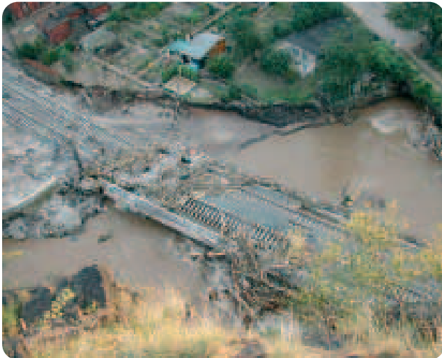
Abbildung 4-1: Erosion, Treibgut- und Geschiebeablagerung im Plauenschen Grund, Vereinigte Weißeritz (Foto: Jan Winkler, 2002)
