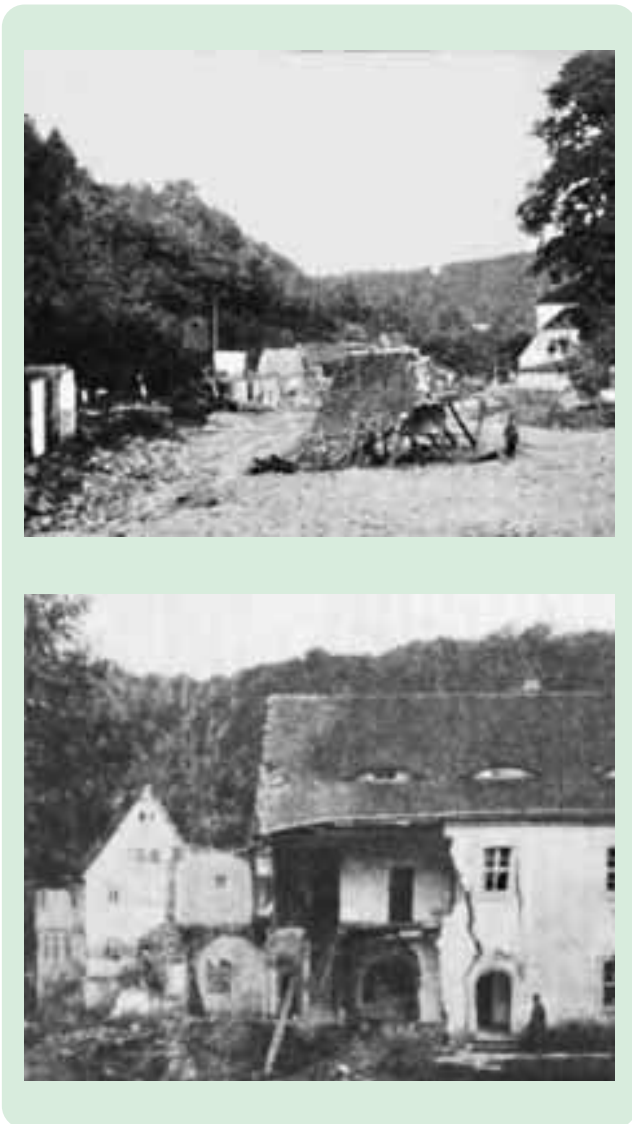
Abbildung 7-13: Hochwasserschäden im Ort Weesenstein im Sommer 1897 (Foto: aus DIE GROSSE WASSERSNOT IN SACHSEN 1897, 1897)
