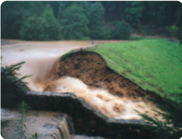
Abbildung 7-3: Abfluss durch die Dammscharte um 16:20 Uhr (Foto: LTV, 2002)
