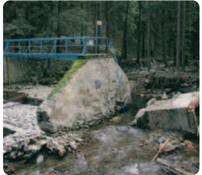
Abbildung 2-13: Zerstörungen am Pegel Ammeldorf/Wilde Weißeritz (Foto: LTV, 2002)
