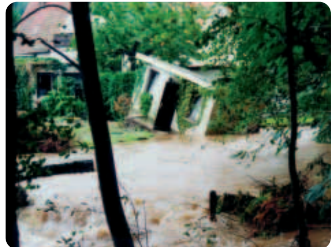
Abbildung 7-24: Durch das Hochwasser zerstörte Gebäude am Lockwitzbach (Foto: Umweltamt Dresden, 2002)
