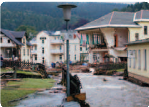
Abbildung 12-15: Zerstörte Schule und neuer Fließweg des Pöbelbaches nach dem Hochwasser am 12./13.08.2002 in Schmiedeberg (Foto: Gottfried Herold, 2002)
