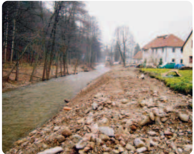
Abbildung 12-6: Schäden durch Ufererosion in Schlottwitz 2002 (Foto: LTV, 2002)
