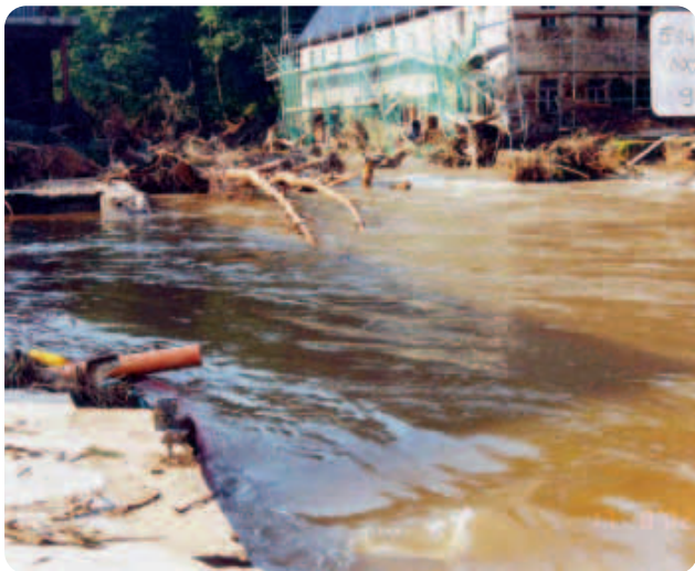
Abbildung 12-8: Schäden durch Erosion, Ablagerung und Ausuferung 2002 (Foto: LTV, 2002)
