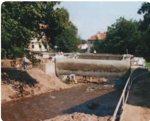
Abbildung 7-20: Schwingwehr an der Tögelstraße nach dem Hochwasser bei den Aufräumarbeiten (Foto: Umweltamt Dresden, 2002)
