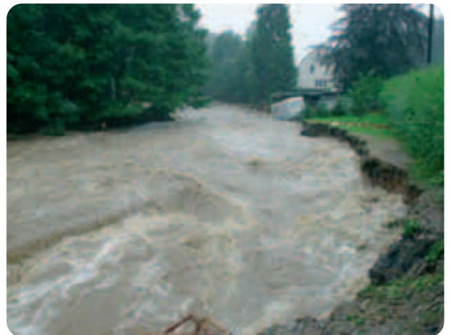
Abbildung 4-6: Überströmung der Ufermauer und Erosion am Pöbelbach, Schmiedeberg (Foto: Olaf Rentsch, 2002)
