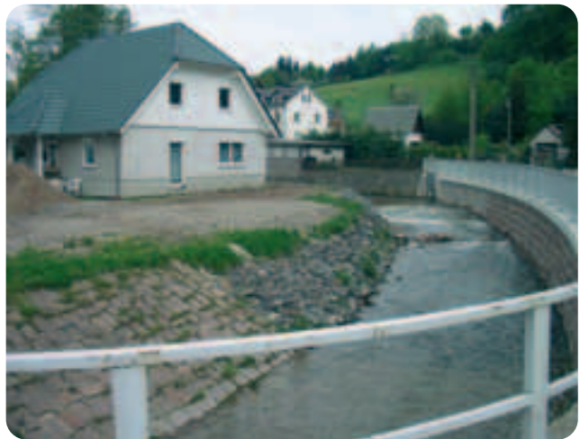
Abbildung 9-4: Triebisch in der Ortslage Grund – Im Bild von rechts nach links: massive Stützmauer für Straße am Prallhang, Sohlrampe anstelle eines ehemaligen Schützenwehres, Stein-schüttung als Ufersicherung an der Kurveninnenseite, Neubau eines Einfamilienhauses nach dem Hochwasser August 2002 im Überschwemmungsgebiet (Foto: LfUG, 2004)
