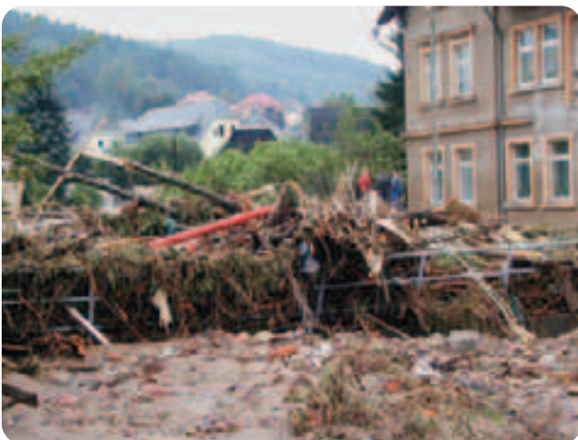
Abbildung 12-16: Verklauste Brücke nach dem Hochwasser am 12./13.08.2002 in Schmiedeberg (Foto: Gottfried Herold, 2002)
