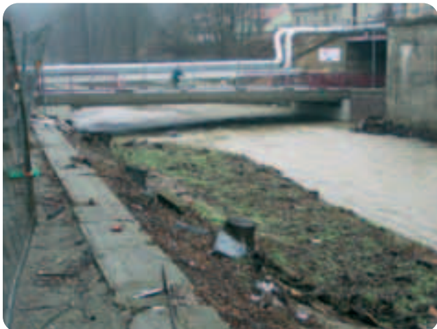
Abbildung 9-1: Straßenbrücke über die Triebisch (Durch-fluss ohne Freibord ca. HQ(50)), Stadtgebiet Meißen (Foto: Lukas Hunzinger, 2003)
