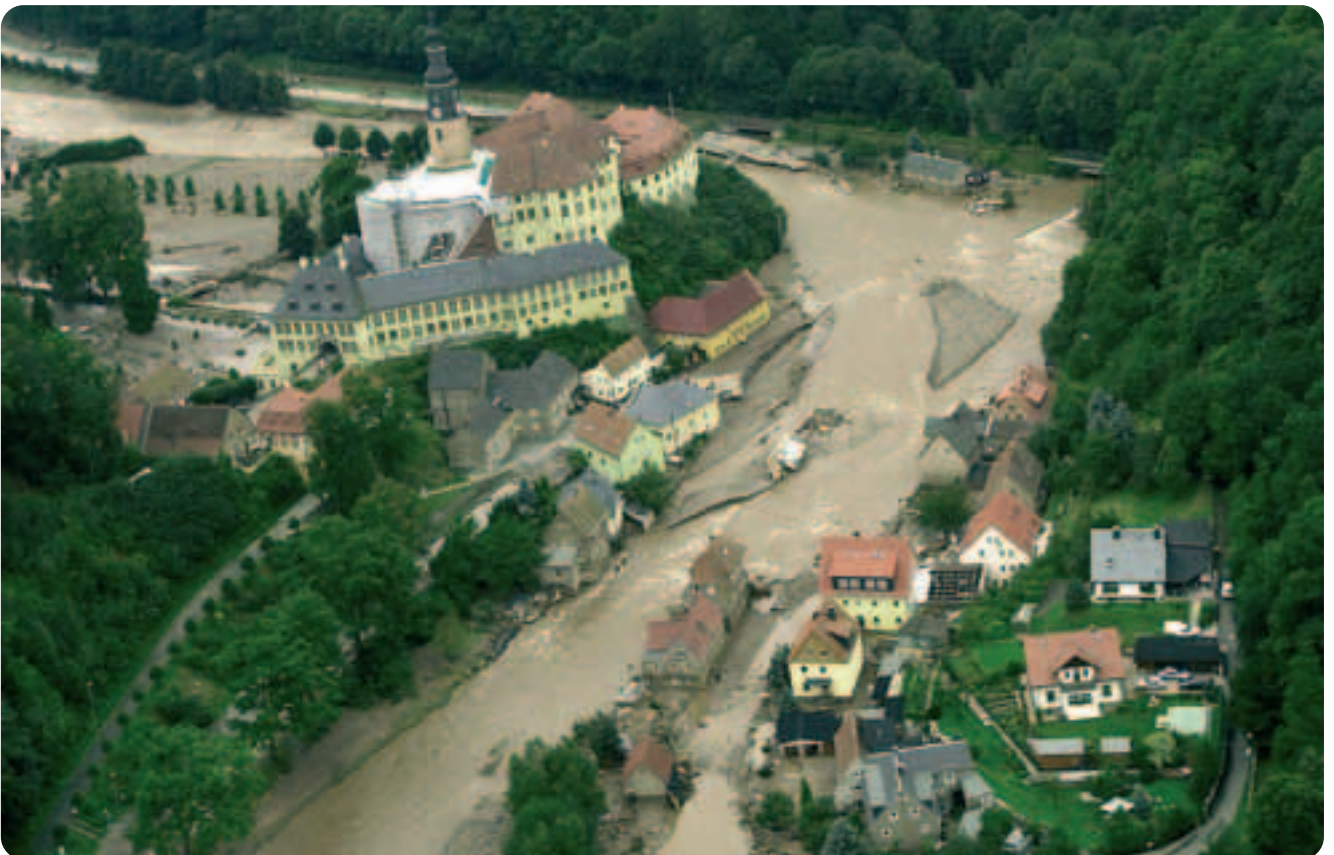
Abbildung 7-11: Blick auf den unteren Teil der beim Augusthochwasser 2002 entstandenen Flutrinne (Foto: Stefan Häßler, 2002)
