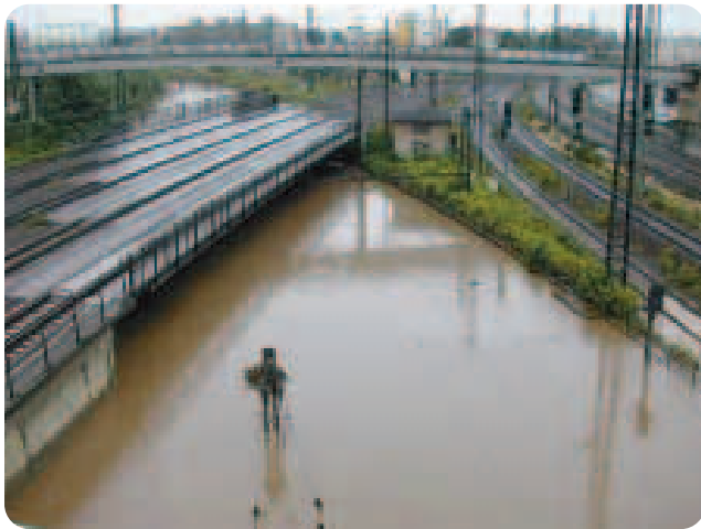
Abbildung 7-30: Vereinigte Weißeritz entlang der Tiefgleise Richtung Hauptbahnhof am 13. August (Foto: Jan Winkler, 2002)
