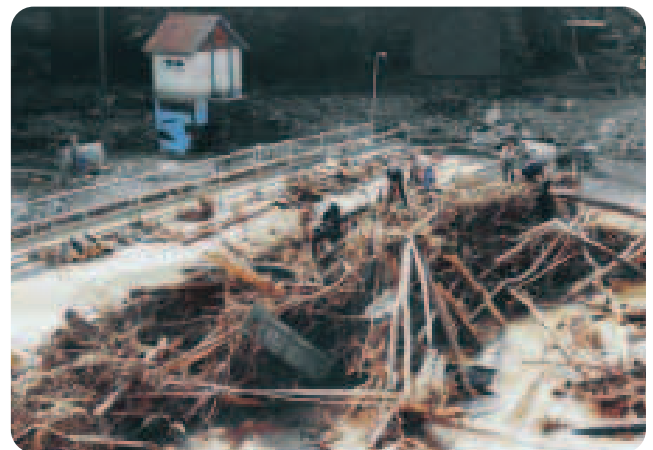
Abbildung 3-9: Verklauste und beschädigte Müglitzbrücke, Behelfsbrücke Schlottwitz oberhalb der Mündung des Trebnitzgrundbaches (Foto: LTV, 2002)
