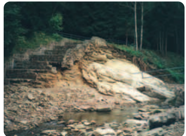
Abbildung 7-5: Dammbrechestelle nach dem Hochwasser (Foto: LTV, 2002)
